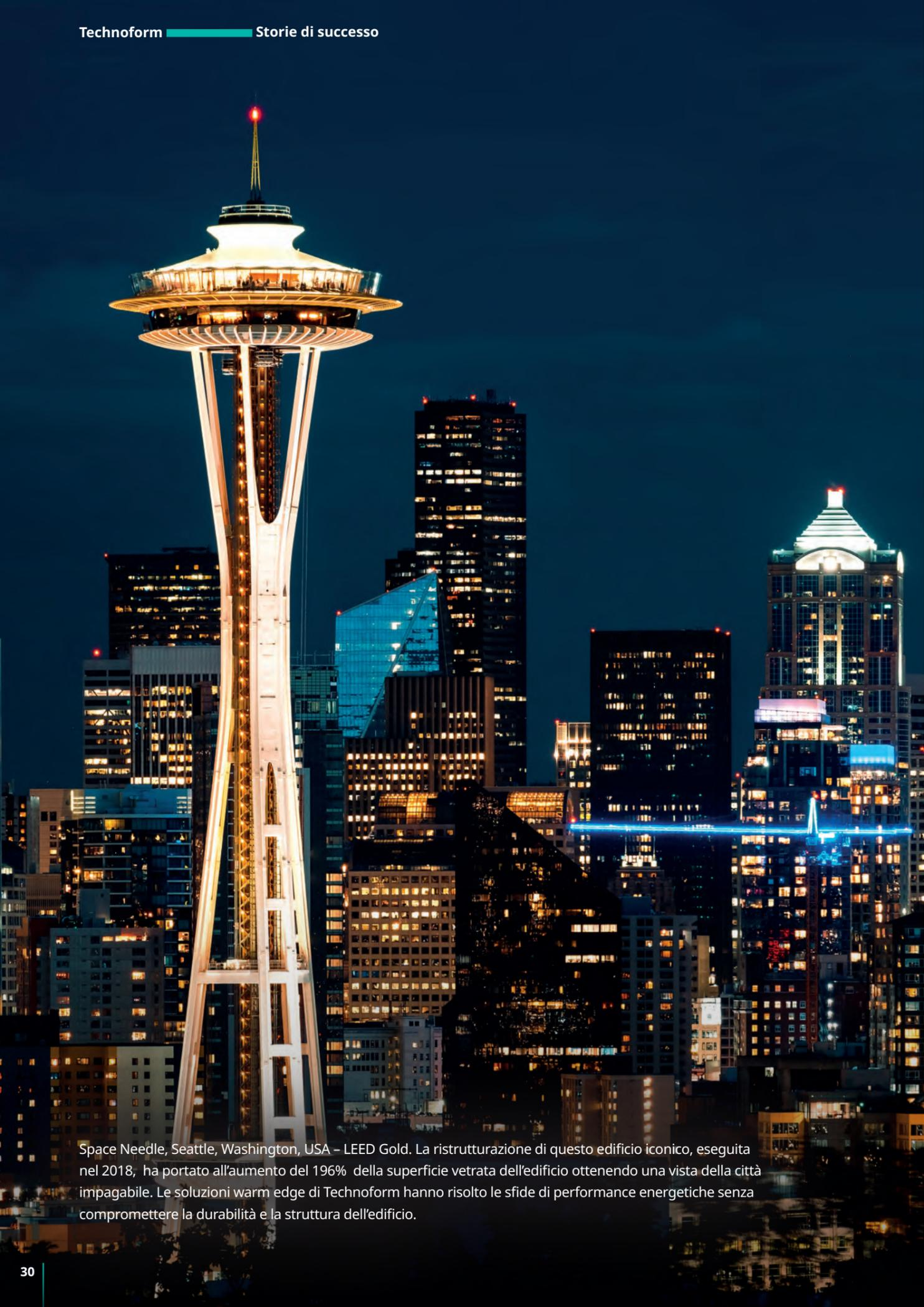
Space Needle, Seattle, Washington, USA – LEED Gold. La ristrutturazione di questo edificio iconico, eseguita nel 2018, ha portato all'aumento del 196% della superficie vetrata dell'edificio ottenendo una vista della città impagabile. Le soluzioni warm edge di Technoform hanno risolto le sfide di performance energetiche senza compromettere la durabilità e la struttura dell'edificio.
